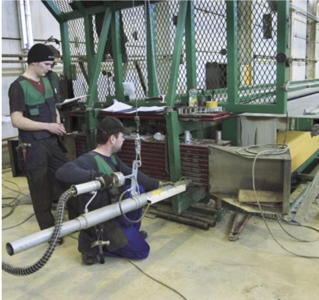
Esa Koutonen (oik.) jännittää TT-laatan vajereita YBT:n Ylitornion tehtaalla. Vieressä Timo Huhtanen.
