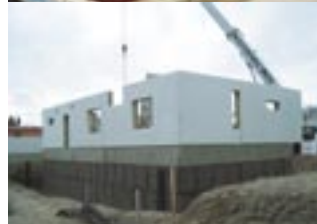
Solidus messutalon julkisivu on valmistettu kevyesti hiekkapuhalletusta valkobetoniasta. Kuvassa Jorma Piisinen kuvauskeikalla Ylitornionla.
