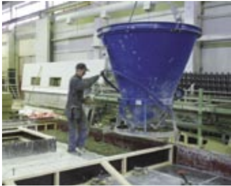
Betonelementit valmistetaan ja varastoidaan lämpimissä ja kuivissa tehdasolosuhteissa.
