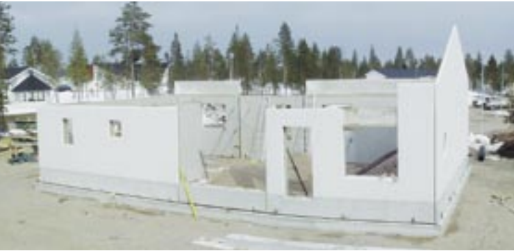
Lampisten talon elementtien asennus aloitettiin klo 9.00. Kaikki elementit olivat asennettu paikoilleen klo 14:30 mennessä.
